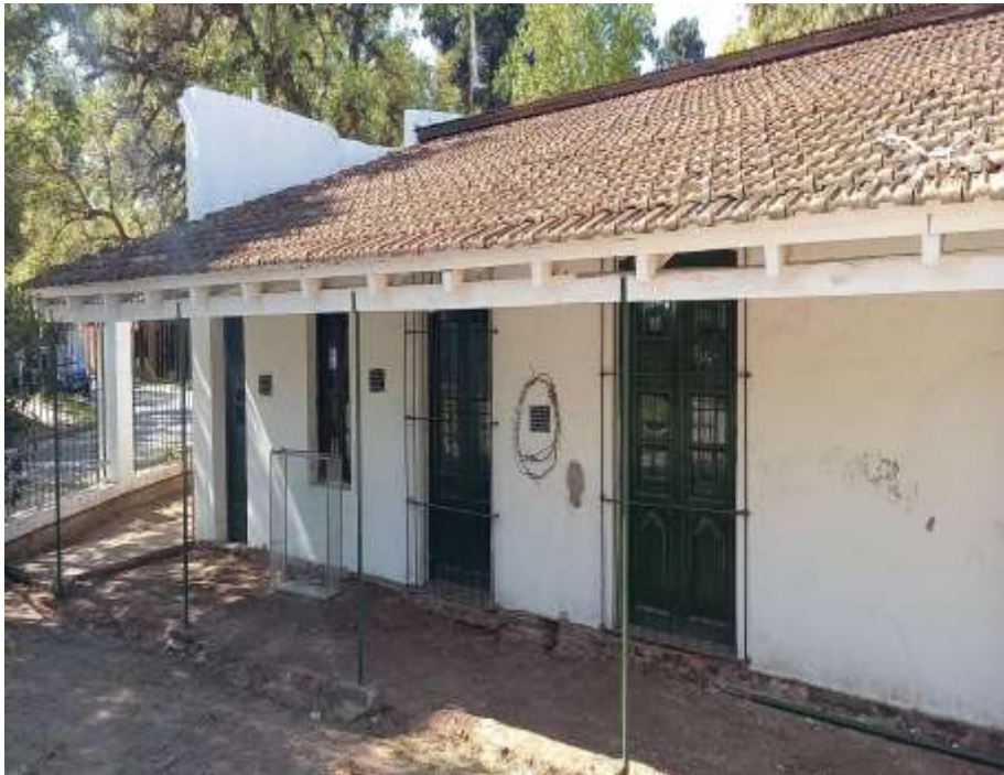
Figura 6. Fotografía actual de la vivienda construida en 1836. Fuente: Archivo Arqueoterra.
