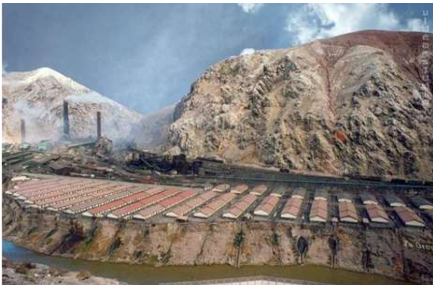
Figura 7. Vista del campamento de obreros Club Peruano. Fuente: https://www.flickr.com/photos/lluquish/9721802512/in/album-72157635366077549/
