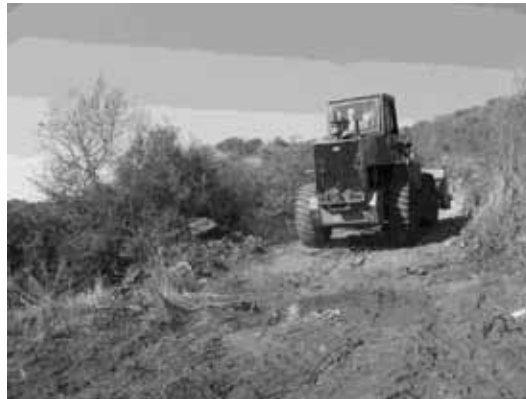
FIGURA 7: Construcción de calle de acceso.
