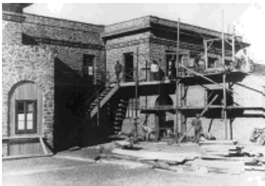
Figura 6 – Obra Edificio de Administración Comodoro Rivadavia.
