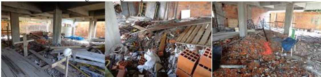
Figura 2 – Organização encontrada no canteiro de obra
