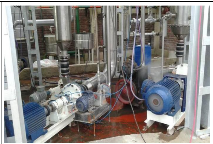
Figura 5: Bombas del evaporador Fuente Rubio y Asociados
