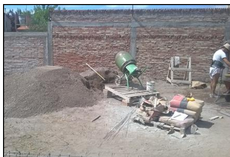
Figura 1. Obra típica en la ciudad de San Rafael.
