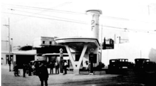
Figura 9. Estación de Servicio en Concordia, Entre Ríos
