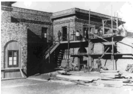
Figura 6 – Obra Edificio de Administración Comodoro Rivadavia.
