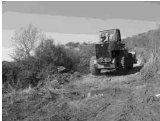
FIGURA 7: Construcción de calle de acceso.
