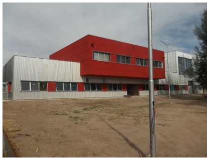
Fig 1. Vista exterior de edificio
