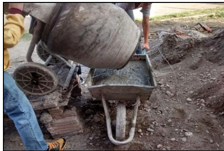
Figura 2. Pastón completo para moldeo de probetas.
