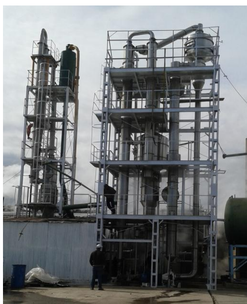
Figura 3: Vista del conjunto luego de ser modificado
