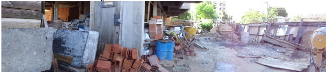
Figura 1 – Primeira vista do canteiro de obras
