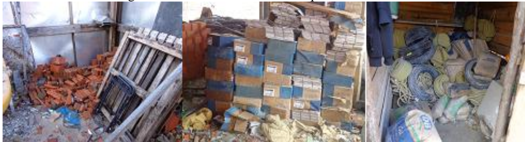
Figura 5 – Condicionamento inadequado dos materiais
