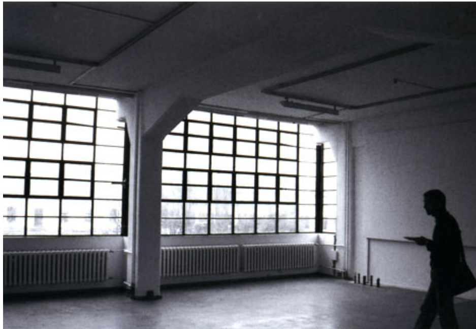
Edificio de Dessau (1925-1932).
