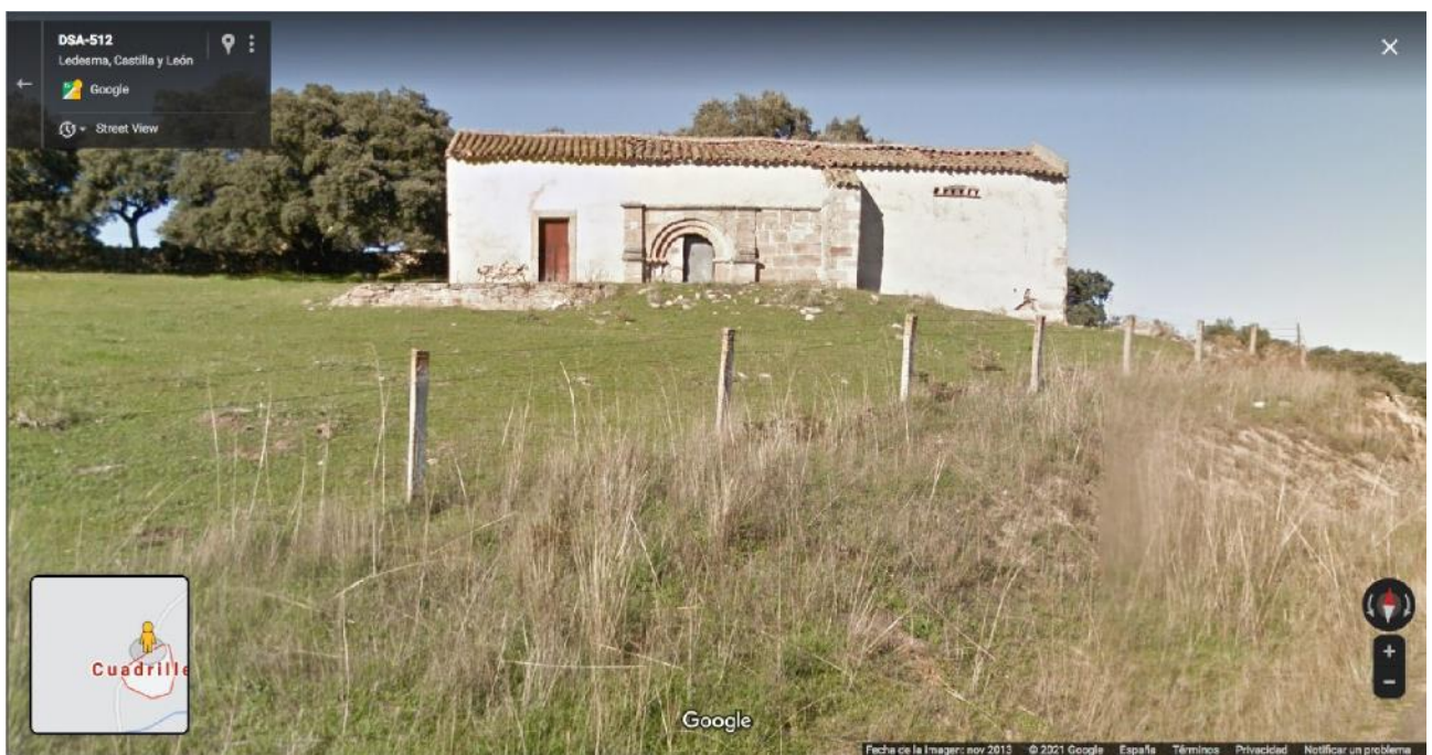
Figura 2. Iglesia en una finca privada no visitable.
