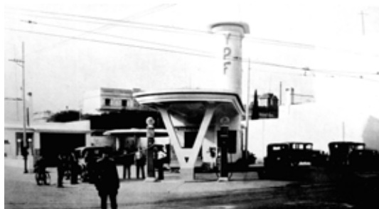
Figura 9. Estación de Servicio en Concordia, Entre Ríos
