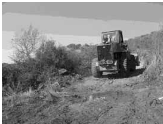
FIGURA 7: Construcción de calle de acceso.
