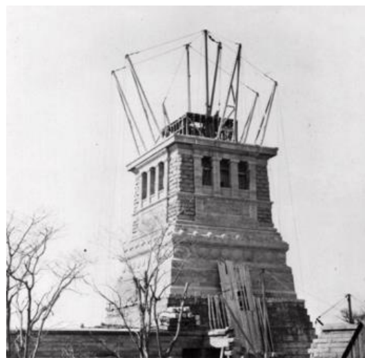
Construcción del pedestal de la Estatua de la Libertad. La estructura de piedra fue diseñada por Richard Morris Hunt. - Anónimo 1886 / Instituto Americano de Arquitectos.
