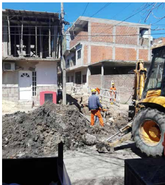
Provisión de agua potable y saneamiento cloacal en la Villa 21-24, como parte del proceso de urbanización que exige el fallo "Mendoza".
