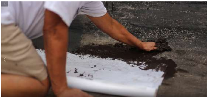
Ilustración 7. Bety y su trabajo de impermeabilización. Colonia La Fama, Tlalpan.
