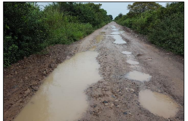
Fotografía 24. Estado de la vía de acceso durante el invierno.
