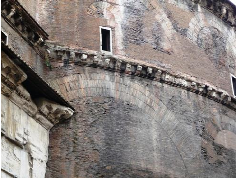
Fig. 10. Marcas de estructura al exterior del edificio. Disponible en:
