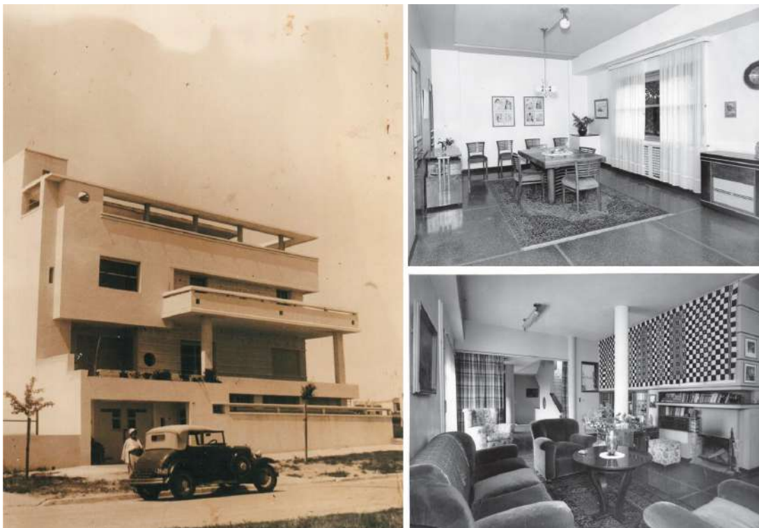
Fig. 4. Fotografías de la vivienda Cravotto (Fundación Cravotto)
