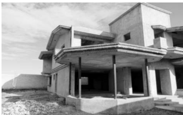
FIGURA 10. VIVIENDA CONSTRUIDA POR MIGRANTES INCONCLUSA EN LA MAGDALENA TÉTELA MORELOS
