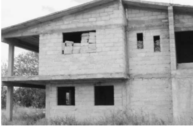
FIGURA 13. VIVIENDA CONSTRUIDA POR MIGRANTES SUB UTILIZADA COMO BODEGA EN OBRA NEGRA EN LA MAGDALENA TÉTELA MORELOS
