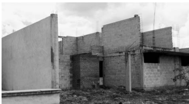
FIGURA 6. VIVIENDA RURAL MODERNA DE BLOCK DE CONCRETO EN LA MAGDALENA TÉTELA MORELOS
