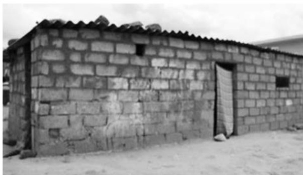
FIGURA 2. VIVIENDA RURAL DE ADOBE EN LA MAGDALENA TÉTELA MORELOS
