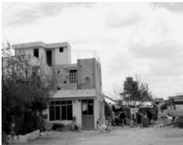
FIGURA 5. VIVIENDA RURAL RECONSTRUIDA O REMODELADA EN LA MAGDALENA TÉTELA MORELOS
