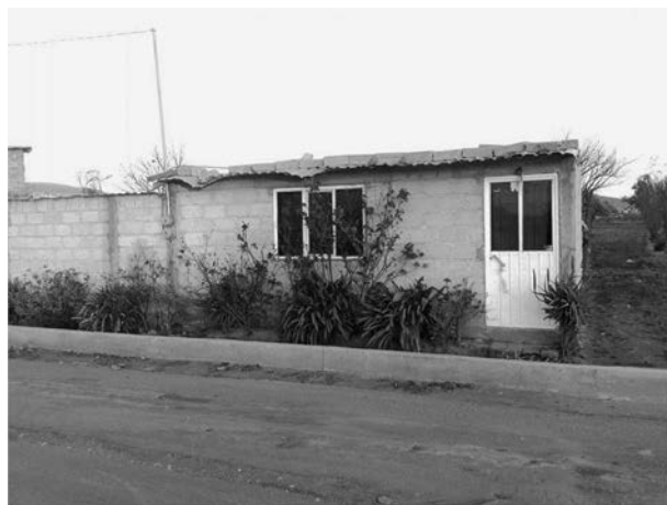
FIGURA 4. VIVIENDA RURAL CONSTRUIDA CON BLOCK DE CEMENTO EN LA MAGDALENA TÉTELA MORELOS
