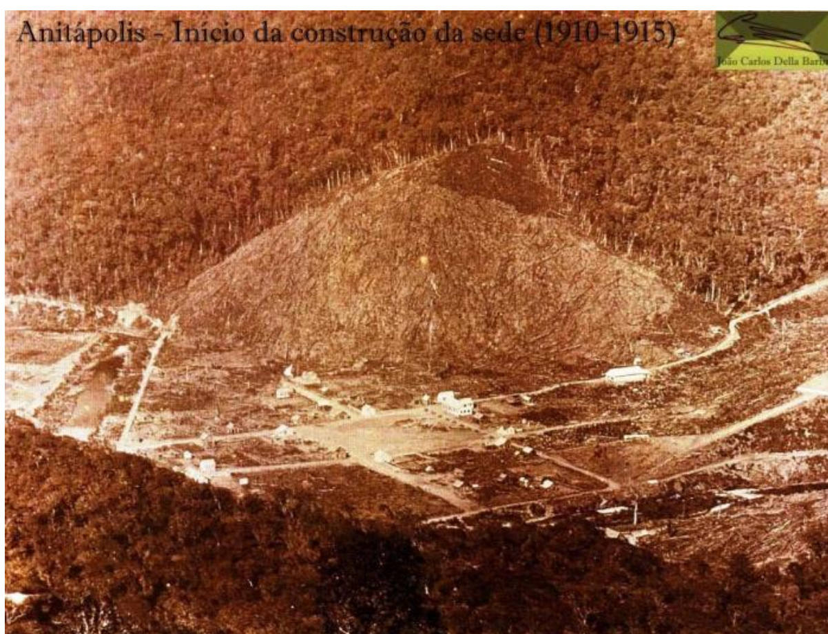
Figura 5 – Início da construção da sede do Núcleo Colonial Anitápolis – 1910 - 1915 21
