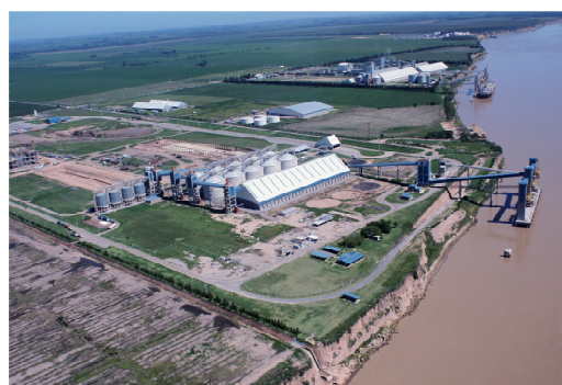
Figura 10: Foto tomada en febrero de 2009. Proporcionada por el Secretario de Obras Públicas de la Comuna. 21 de mayo de 2009.
